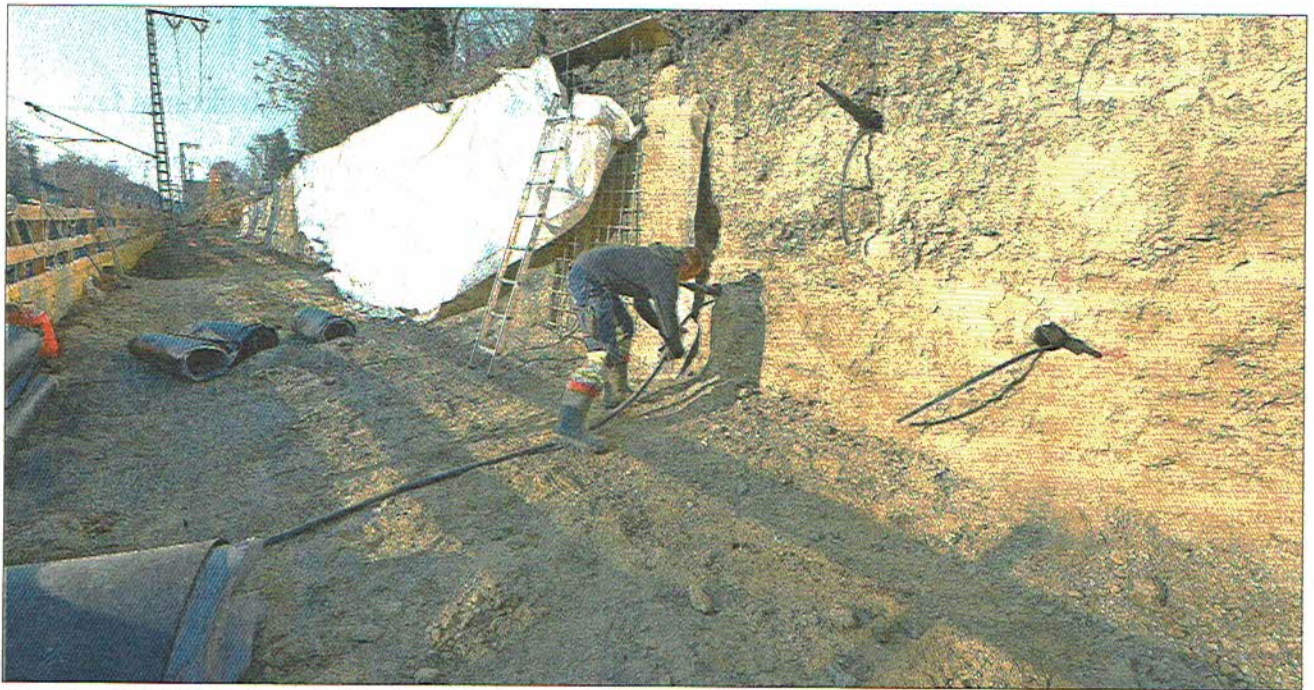
Ein gutes Stück Weg legten Arbeiter schon an, um den Hang mit Ankern und Beton zu sichern. FOTO: INGO SCHNEIDER
